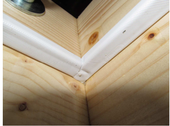
Bild 4 Dichtungsstoß
